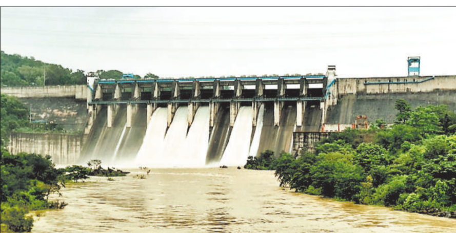
बांगो बांध का 4 गेट खोलकर छोड़ा जा रहा पानी।
